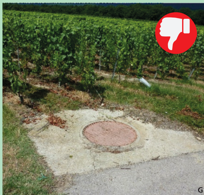
Il faut prendre les mesures utiles pour éviter les risques de contamination des canalisations et des regards d'eau !
