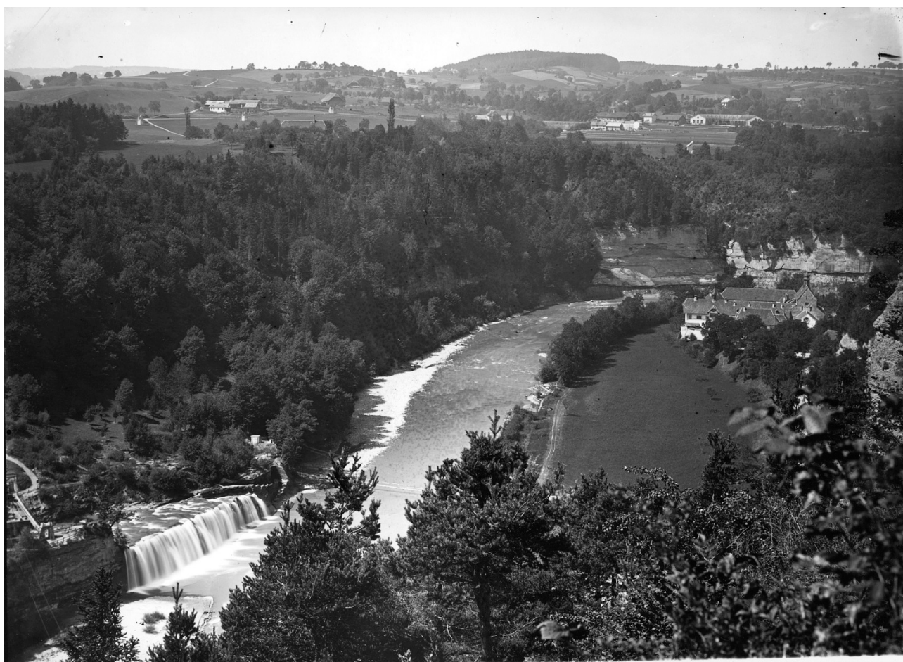
Chute du barrage de la Maigrauge et à l'arrière-plan, le système de câbles et de poulies transmettant la force motrice au plateau de Pérolles. © BCU. Fonds Léon de Weck - Georges de Gottrau
