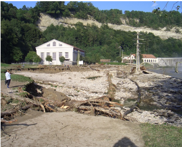
Dégâts causés après la crue au barrage de la Maigrauge © SEn
