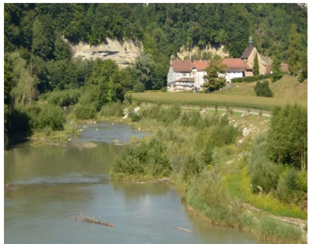
Résultat après les travaux © SEn
