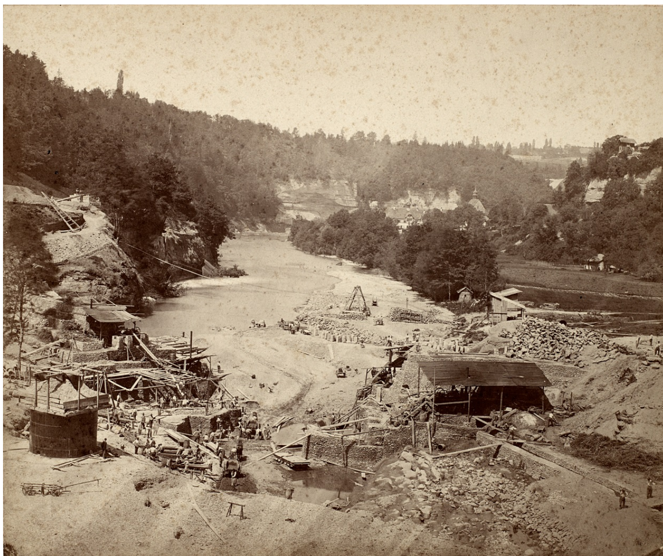
Construction du barrage de la Maigrauge (1872). © BCU. Collection de photos sur carton
