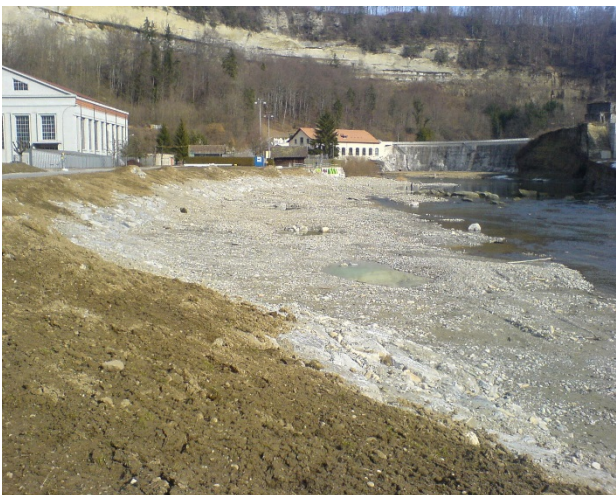
Travaux d'aménagement pour redonner de l'espace à la Sarine suite aux dégâts causés par la crue © SEn
