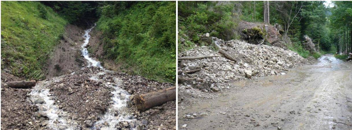
Abbildung 9: Schäden durch das Hochwasser (Erosion und Ablagerung von Material).
