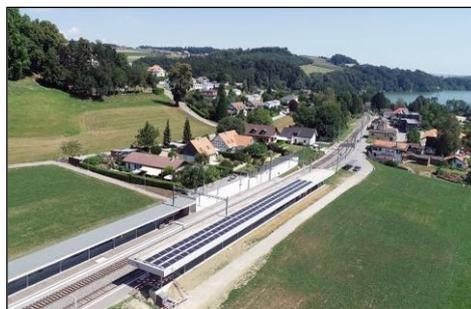
Plusieurs stations d'épuration se sont dotées d'un toit solaire pliable comme la STEP à Esslingen (ZH). Dans le canton de Fribourg, une marquise est équipée d'une installation solaire à la gare de Pensier. Sources : dhp et Climkit
