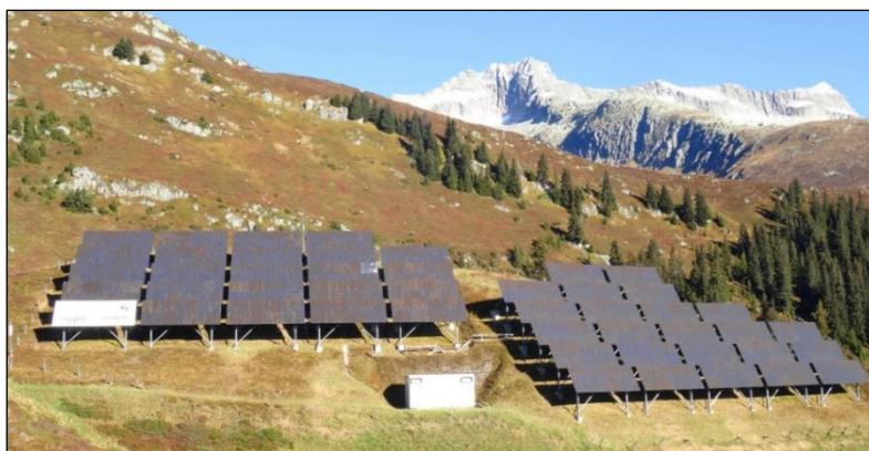
L'installation photovoltaïque de 97,78 kW à Caischavedra (GR) mise en service en mai 1993, avec une production d'électricité en hiver particulièrement intéressante. Source : NET SA
