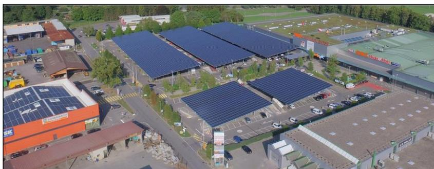
Parking solaire au centre commercial à Aigle (VD) avec une production de 1,8 GWh / an. Source : Romande Energie
