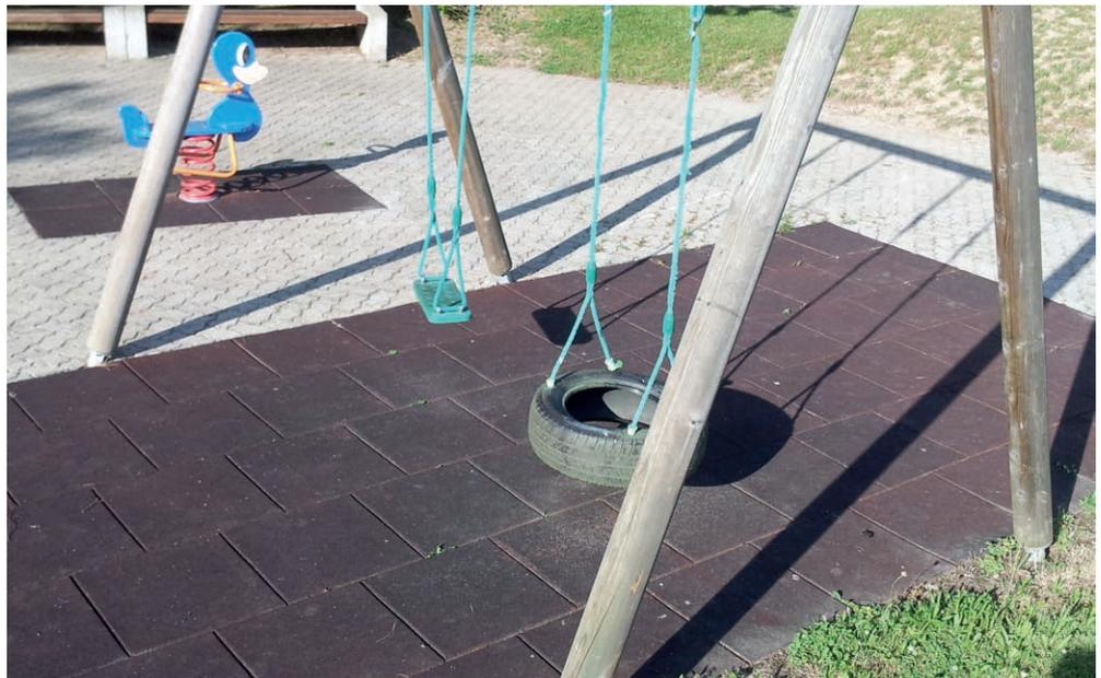
Fallschutzplatten aus Reifengranulat
