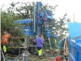
500 m tiefe Bohrung für Erdsonden in Düdingen
